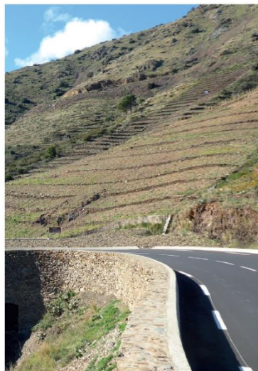
Habillage en parement pierre des MVL
