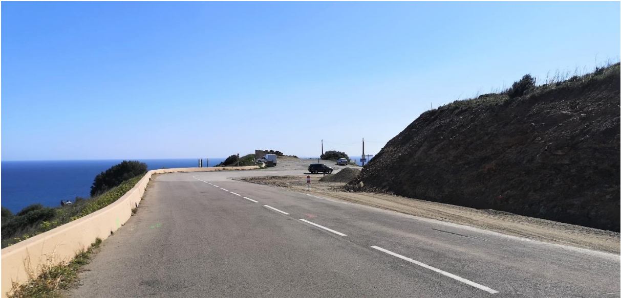
☞ Photographie 1 : Vue du Cap Rédéris depuis la RD914 au Nord
