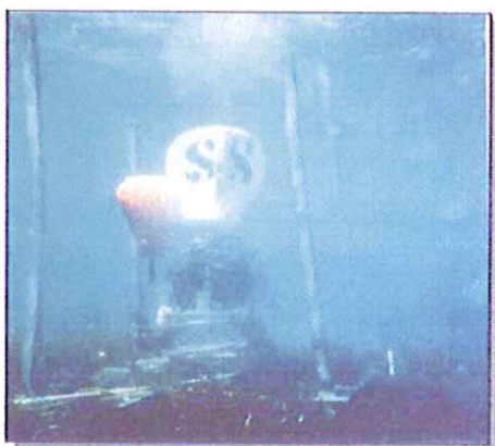
Positionnement d'un enroulement d'acier spécial permettant l'ancrage sans altérer l'herbier à Posidonia Oceanica
