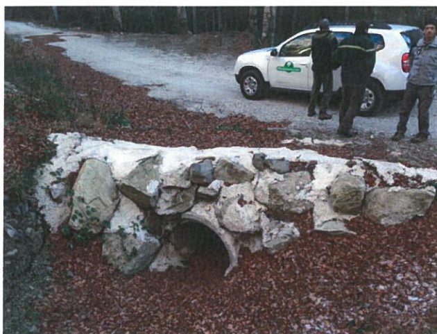
Exemple d'enrochement maçonné (FD de Boucheville, buse de 1000 > à notre projet)
