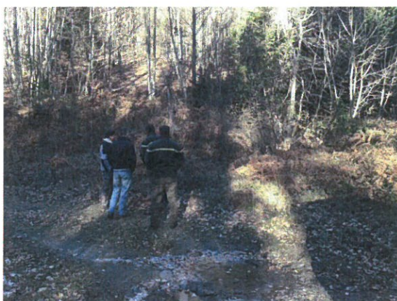
Vue de l'amont du passage busé
