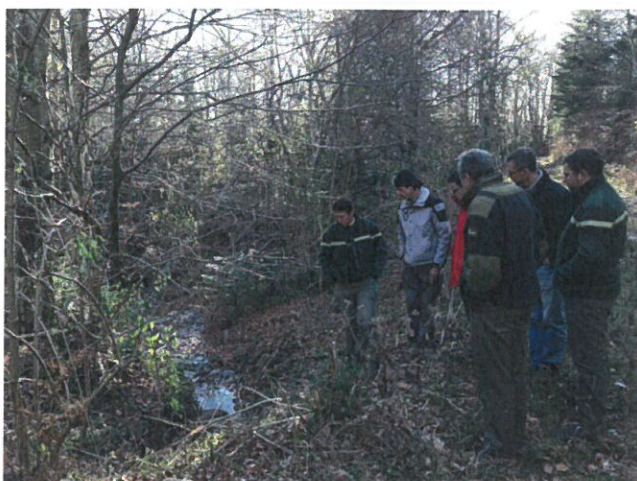
Vue aval du passage busé
