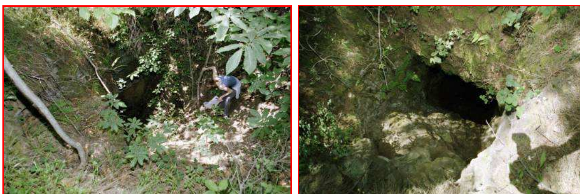
Site n° 222. Escaro. Concession d'Escaro Sud. Puits aérage
