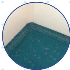
Parois dures, lisses et étanches
