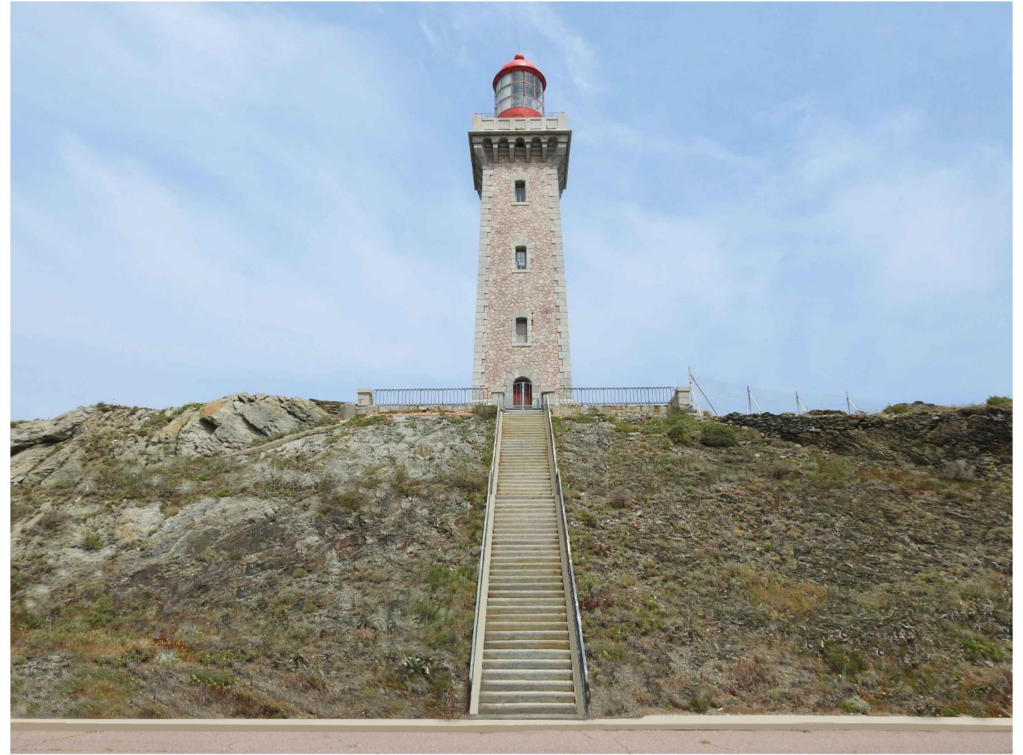
Le projet : Sélection végétale horticole sur le glacis : élimination des Agaves, Griffes de sorcières, Figuier de Barbarie Suppression du muret Restauration de l'escalier
