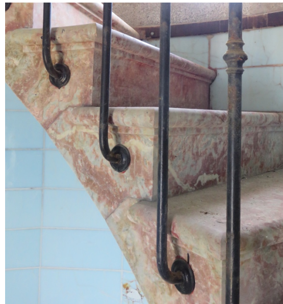
Vue des parties basses de la rampe proche du haut du phare
