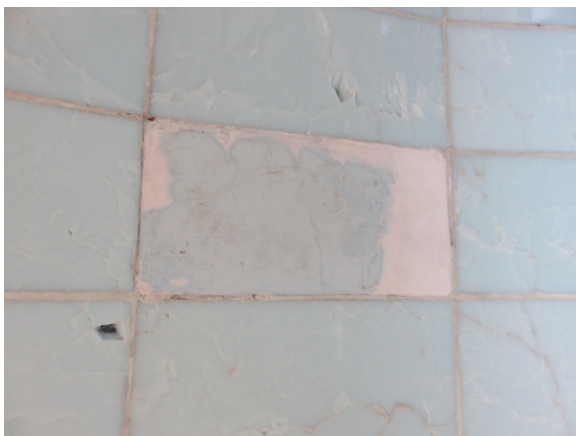
Détail d'un carreau restitué à l'enduit blanc avec une retouche bleue imitant les carreaux
