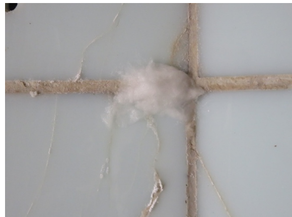
Vue d'une compresse d'eau déminéralisée sur un joint
