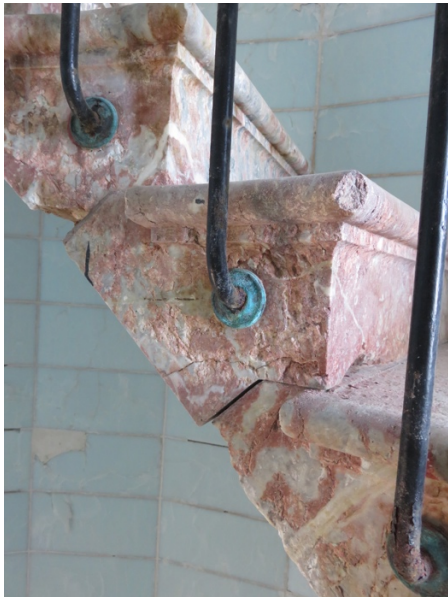
Vue des parties basses de la rampe proche du RDC du phare
