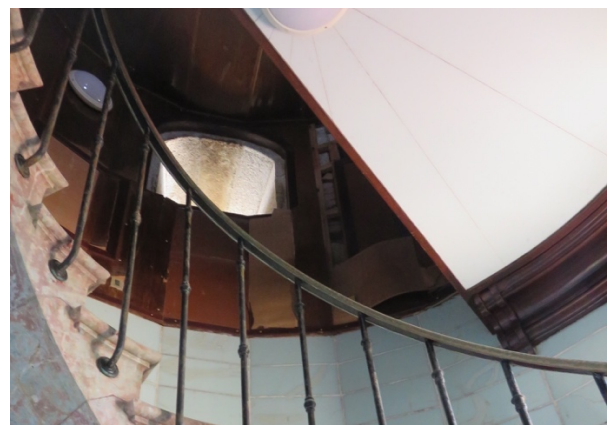
Vue du placage de contreplaqué sur les murs et le plafond de la chambre de service
