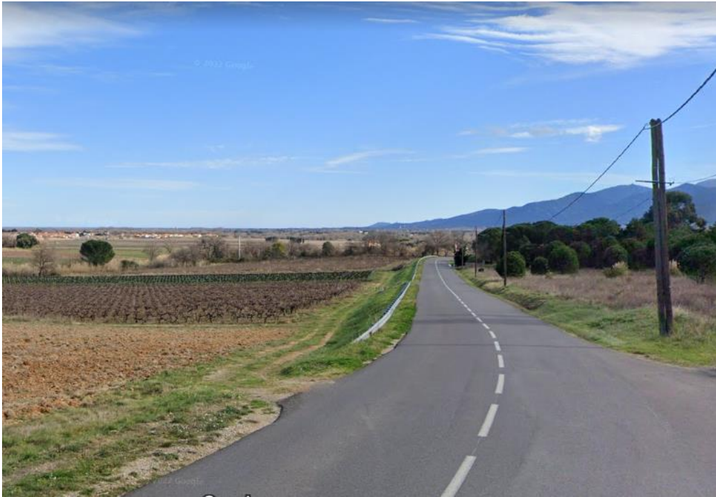
Vue sortie chemin sur RD avant travaux
