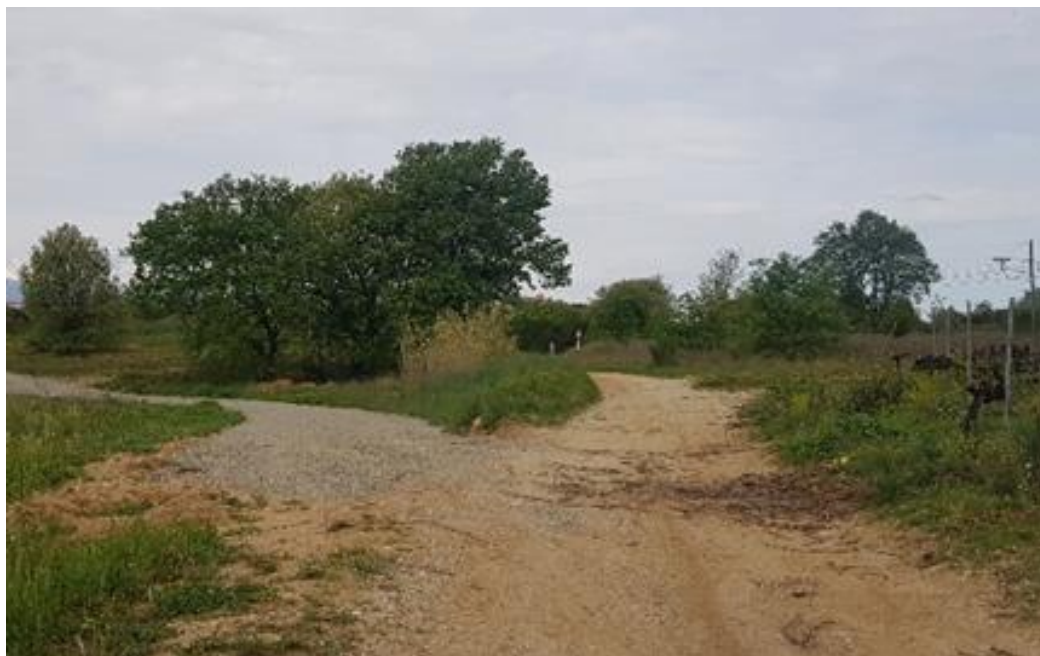
Vue à 200m côté Sud après travaux
