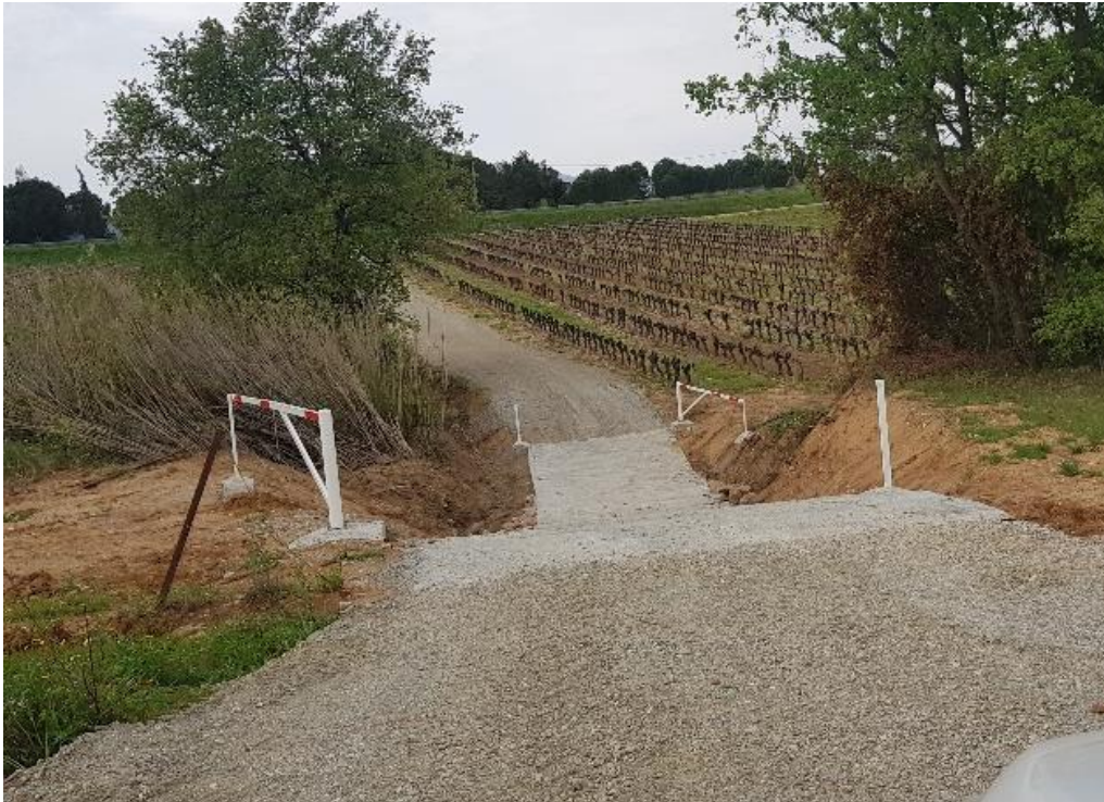
Vue vers passage à gué
