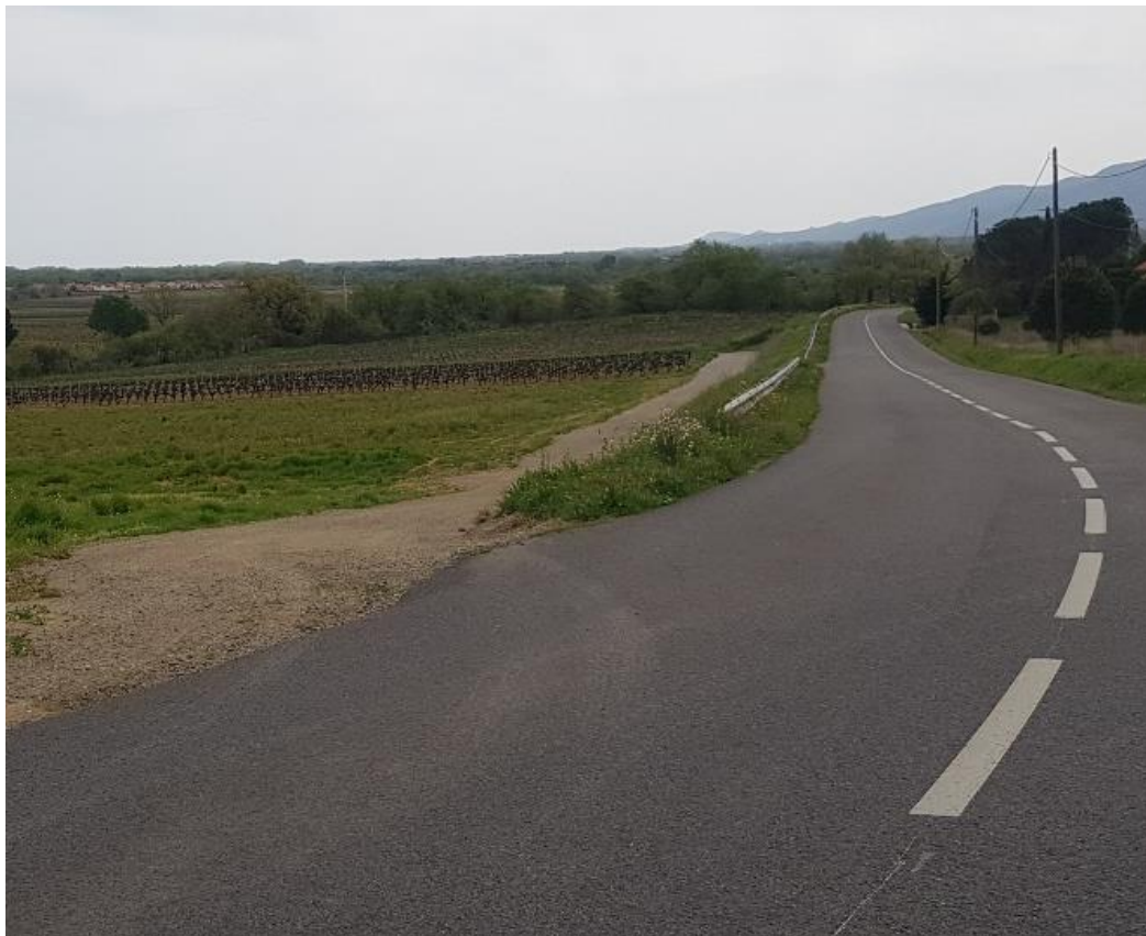
Vue sortie chemin sur RD après travaux
