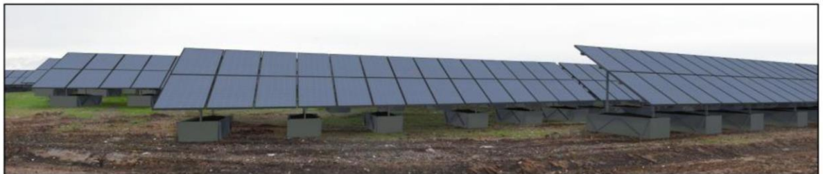
Figure 1 : Exemple de structure fixée sur bacs lestés
