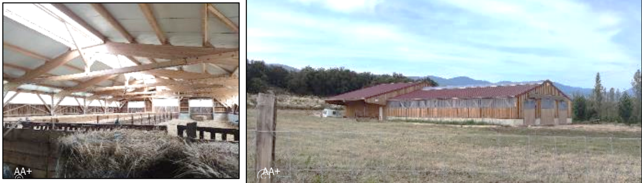
Figure 4 : Bâtiment de stockage-bergerie de Betty DEL BANO
