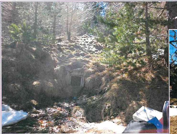
Le captage de Gare Vella vu de l'aval vers l'amont
