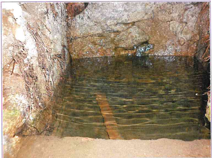
L'intérieur du captage de Gare Vella. Au fond la venue d'eau. On aperçoit les racines qui passent à travers les parois de l'ouvrage.
