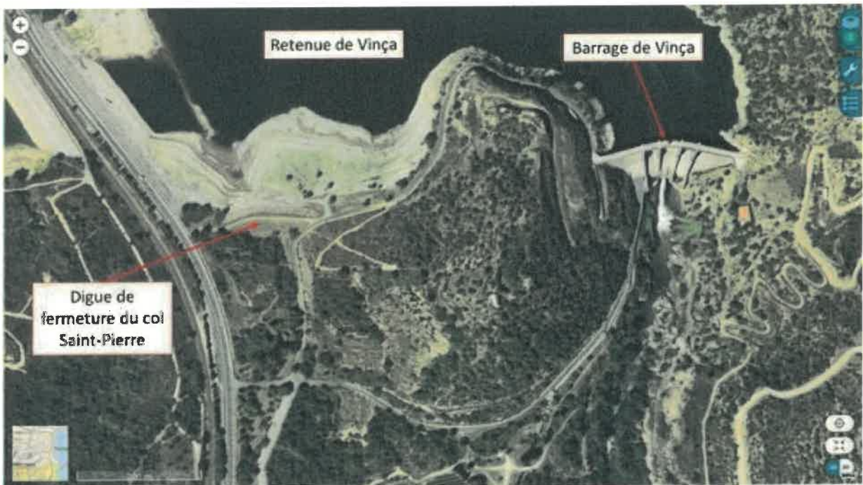
Figure 0-2 : Barrage de Vinça, digue de fermeture du col Saint-Pierre, et retenue de Vinça
