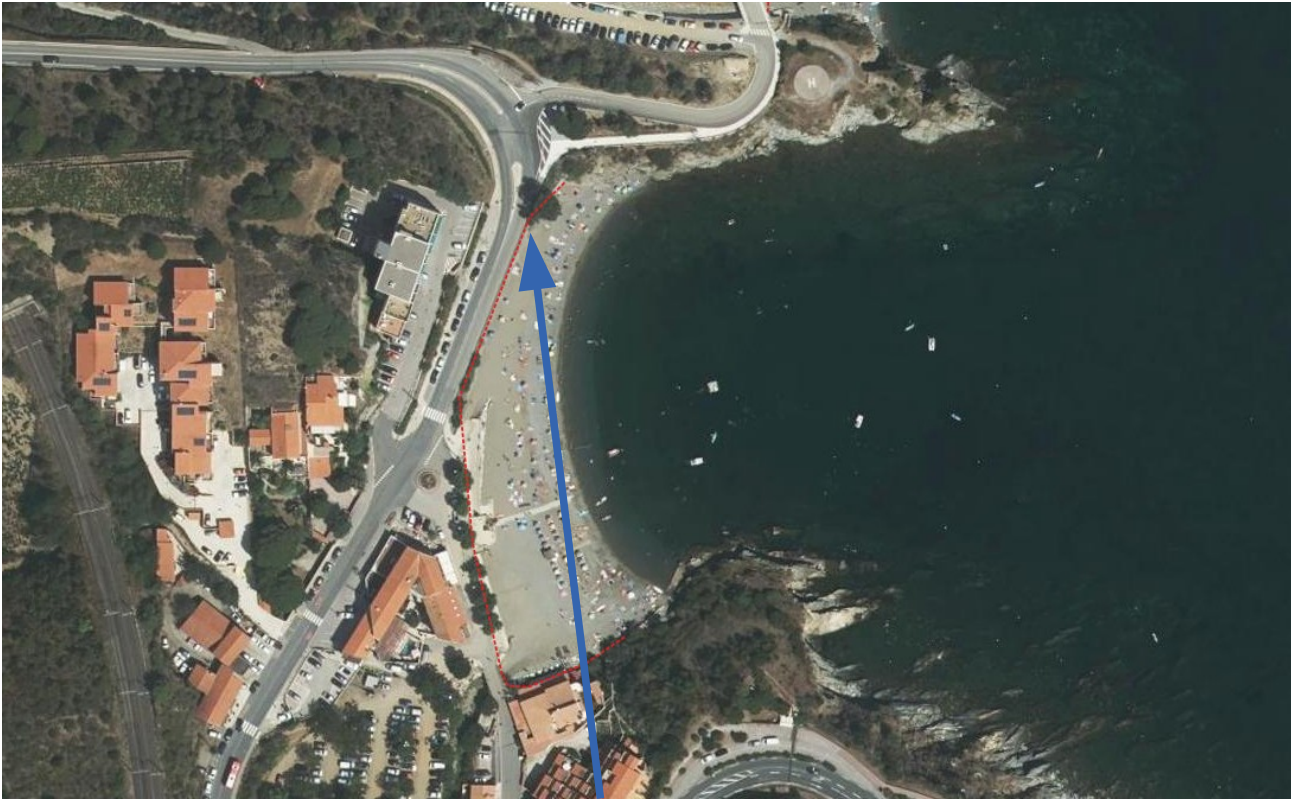
Plage des Elmes - Zone de travaux située au pied du mur à restaurer
