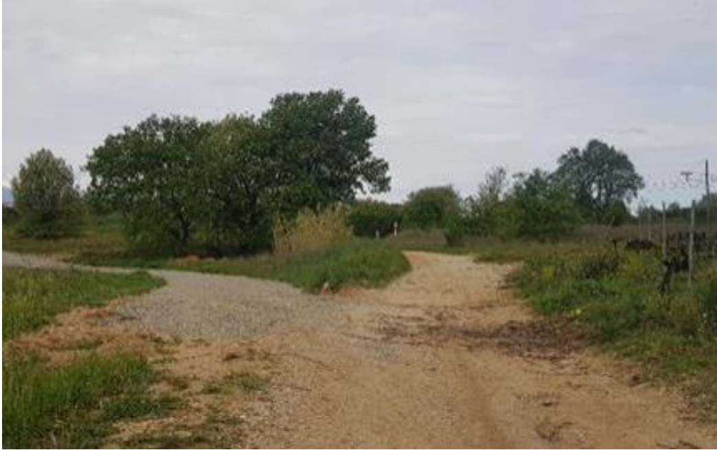
Figure 12 Vue à 200 m côté Sud après travaux
