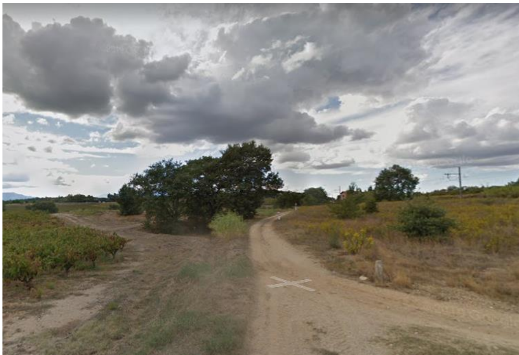
Figure 9 Vue à 200 m côté Sud avant travaux
