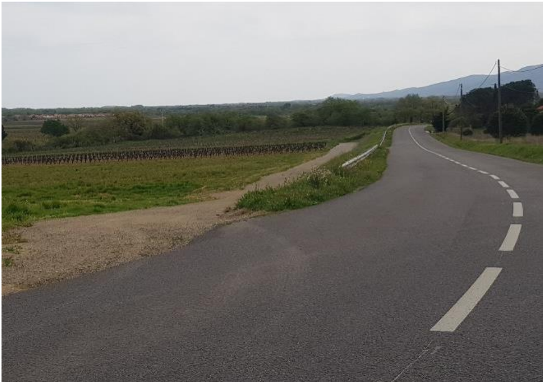
Figure 17 Vue de la sortie du chemin sur la RD après travaux
