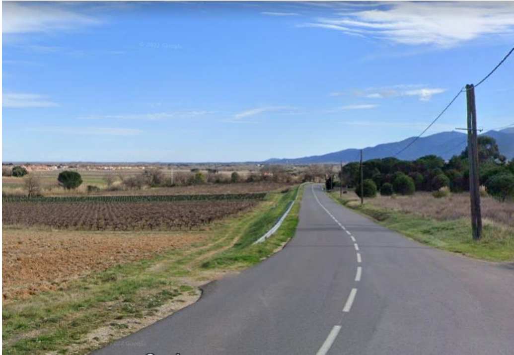
Figure 10 Vue de la sortie du chemin sur la RD avant travaux
