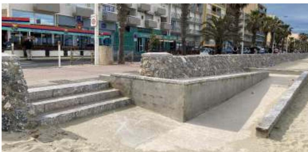
Figure 7 : Exemple de rampe béton PMR
