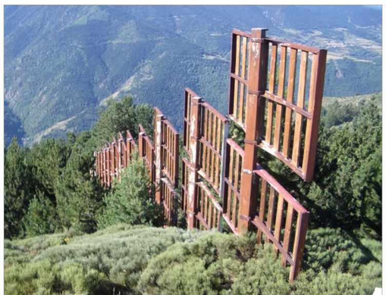
Fontpédrouse Coume-Escale, Barrières à vent, RTM
