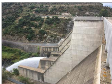
Barrage de Vinca, DREAL Occitanie
