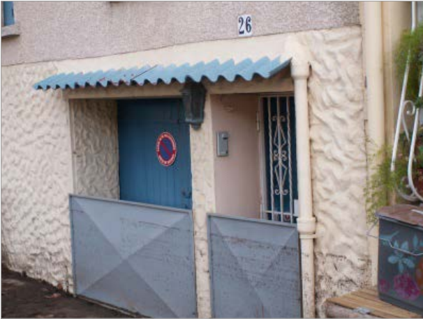
ARGELES-SUR-MER. Batardeaux mis en place ayant permis de ne pas être inondé à l'occasion de la crue de la Massane en novembre 2014 (RTM, 2014)
