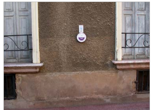
VERNET-LES-BAINS. Repère de crue mis en place dans l'avenue des Thermes pour marquer le niveau atteint par la crue du Cady en octobre 1940. Le crépi est toujours aujourd'hui marqué de l'empreinte du niveau de la crue (RTM, 2015)
