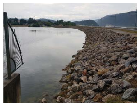
Barrage des Escourmes, Parement, DREAL Occitanie
