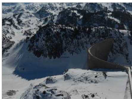
Barrage du Lanoux, DREAL Occitanie
