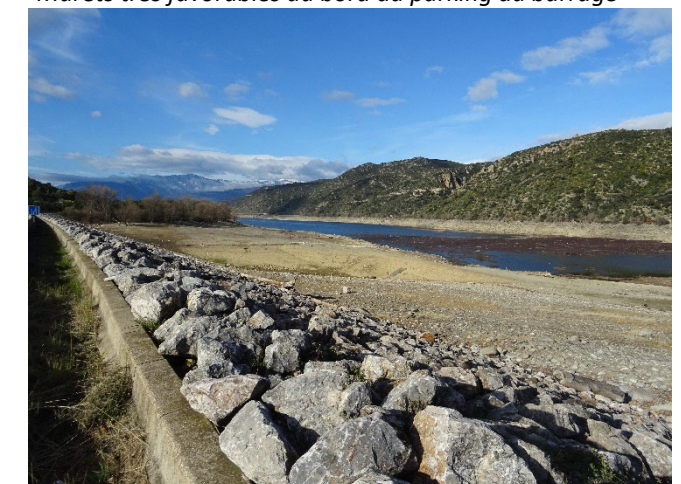
Enrochements du barrage favorable au lézard catalan et à quelques couleuvres
