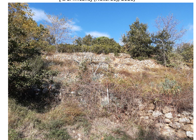
Murets très favorables au bord du parking du barrage
