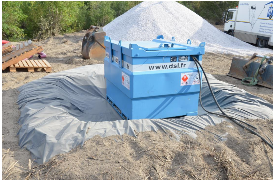
☞ Photographie 23 : Mise en place d'une aire étanche autour d'un groupe électrogène
